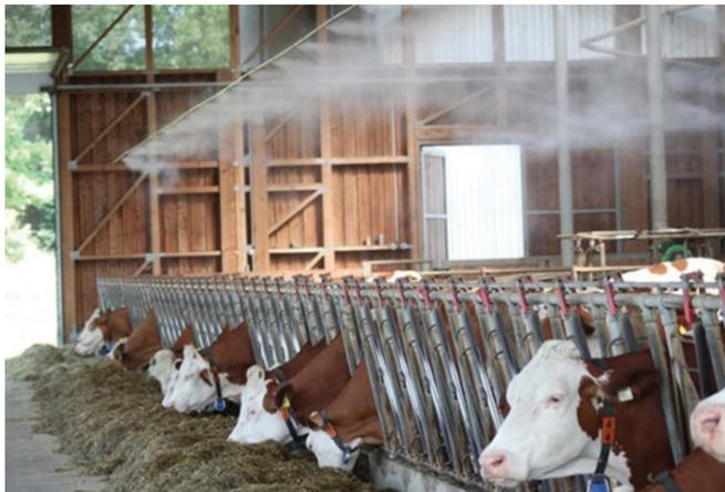
Рис. 1. Охлаждение посредством мелкодисперсного орошения
